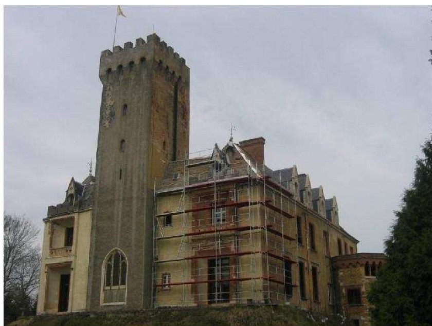
Réfection de l'aile est du château en 2008
