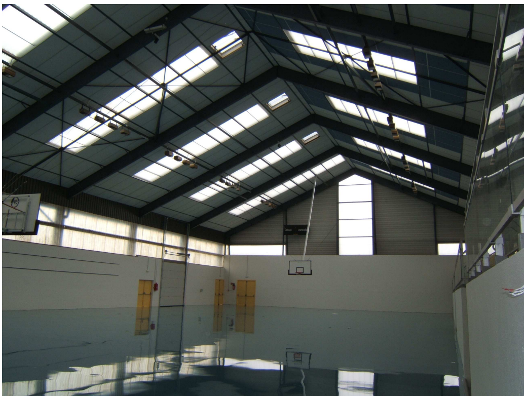
La salle rénovée
