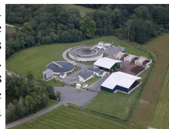
Station d'épuration d'Uzein
