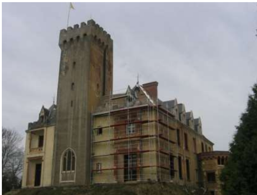
Réfection de l'aile est du château en 2008
