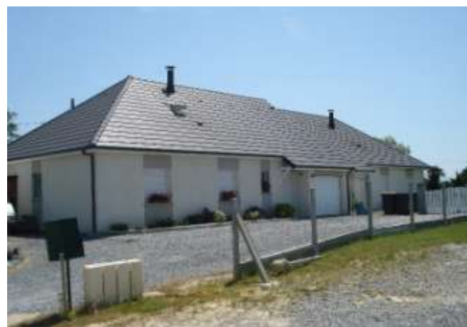
Figure 81 Bâtiment récent à Navailles-Angos
